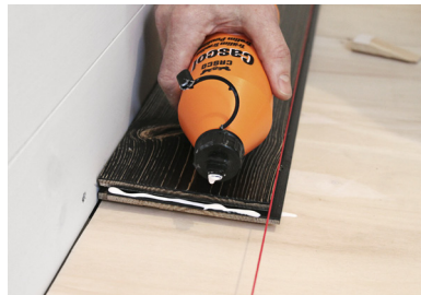
5. Skarva brädor på längden. Limma kortändarna (ej långsidorna).
