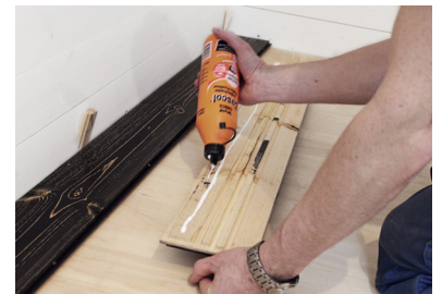
6. Fortsätt läggningen med nästa våd. Lägg en kraftig sträng med trälím under brädan längs hela kanten närmast fjädern/hanen.
