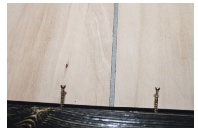
9. Skruvarnas placering Skruva en skruv för varje c/c 400 mm samt på varje sida av en plywoodskarv.
