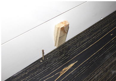
4. Montera första brädan rakt. Använd distanskilar till vägg, ca 5 mm. Limma undersidan (bild 6). Skruva uppifrån vid vägg samt i fjäder (bild 8).
